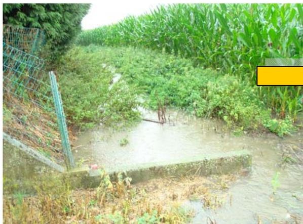
Buse saturée : un grillage bloquant les débris paraît faire obstacle. Possibilité d'installer un barrage plus en amont
