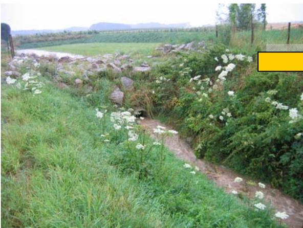
L'eau est montée au niveau du haut de la buse de sortie (traces d'herbe couchée et témoignages)
